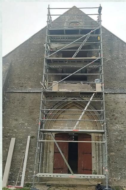
Sur l'église, les travaux de consolidation de la maçonnerie ont été effectués par l'entreprise BODIN de Montebourg, l'ancien vitrail cassé a été enlevé, ensuite les pierres d'encadrement ont toutes été démontées et remplacées. Le coût des travaux de maçonnerie étaient d'un montant de **20 030,20 €**
